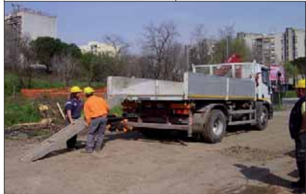
Rimozione seconda pedana
