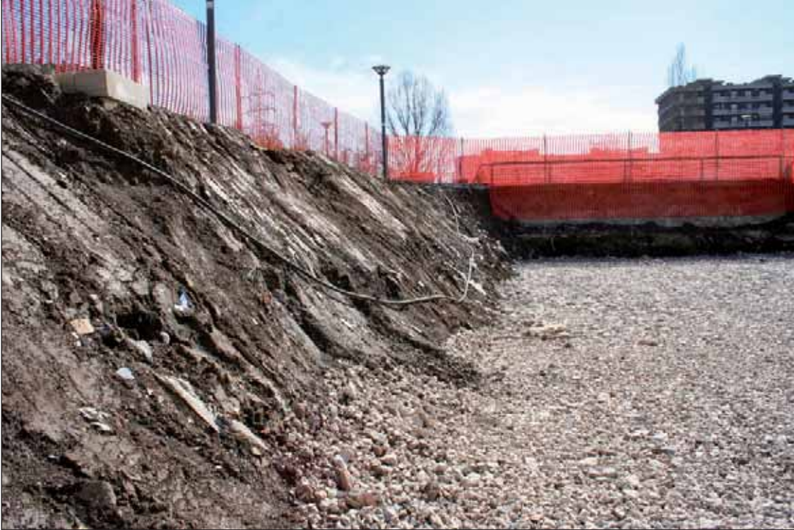
Profilo di scavo a stabilità neturale
