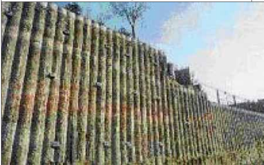
Contenimento del terreno mediante pali in cemento armato accostati
