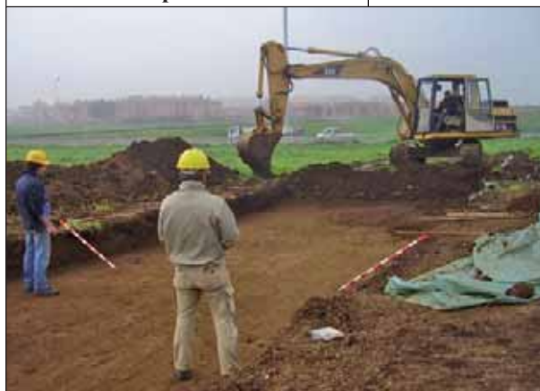
Escavatore in posizione di blocco
