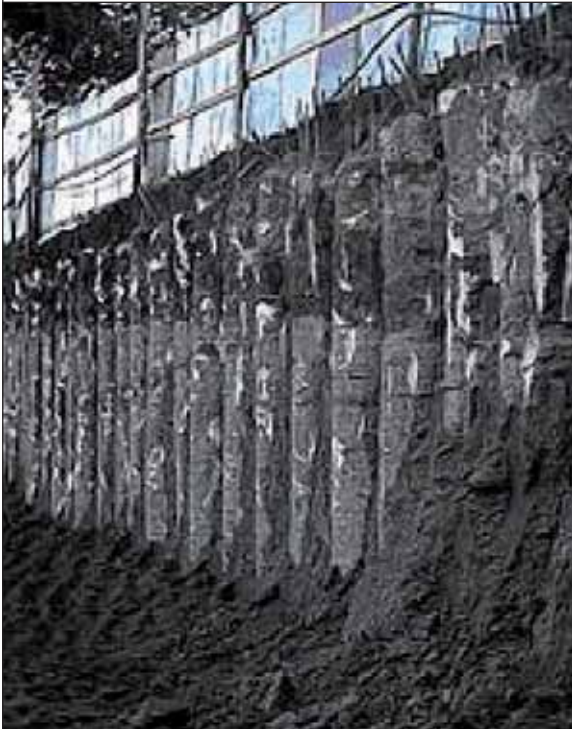
Profilo di scavo contenuto con palificazione
