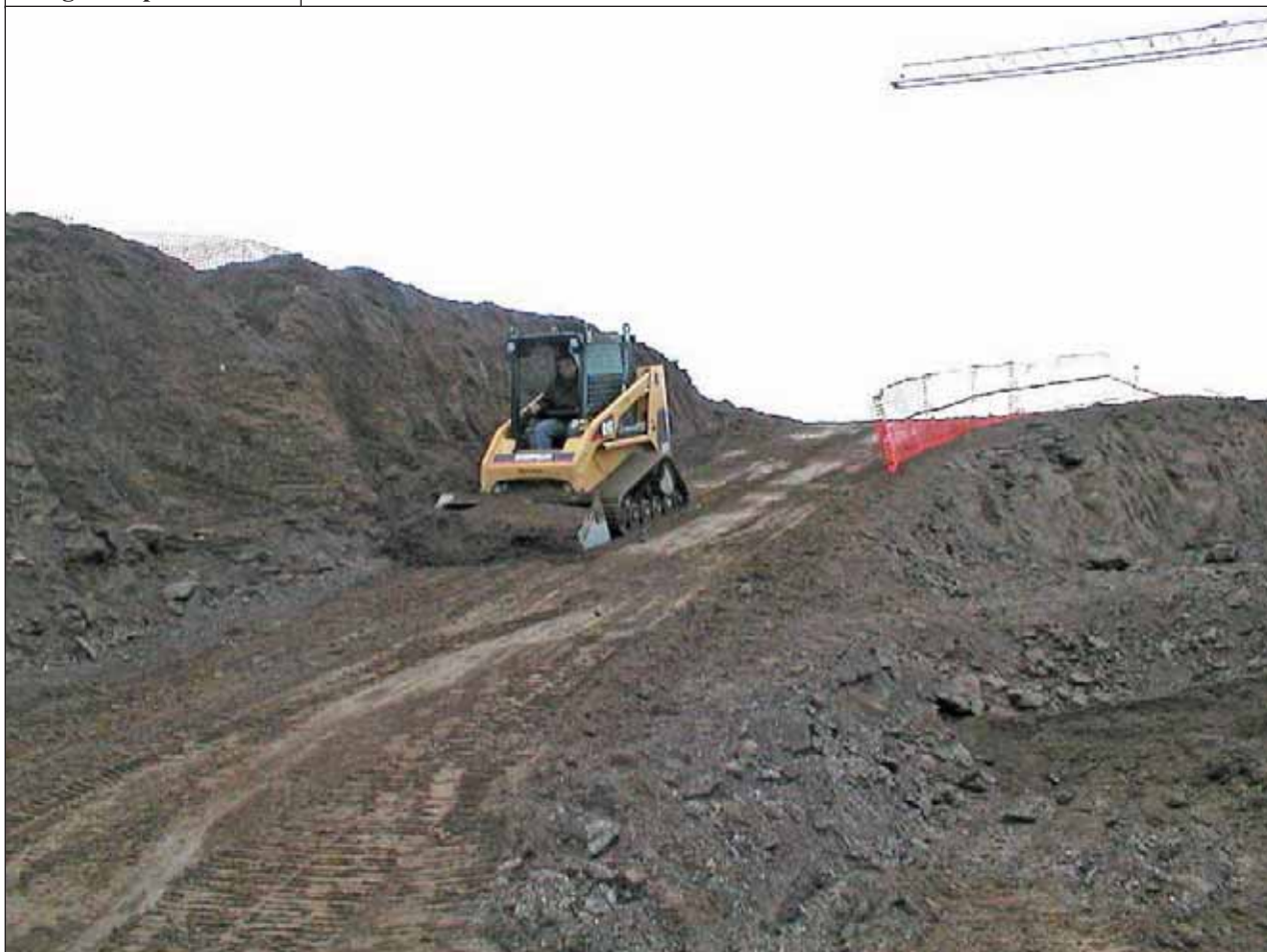
Larga rampa di accesso
