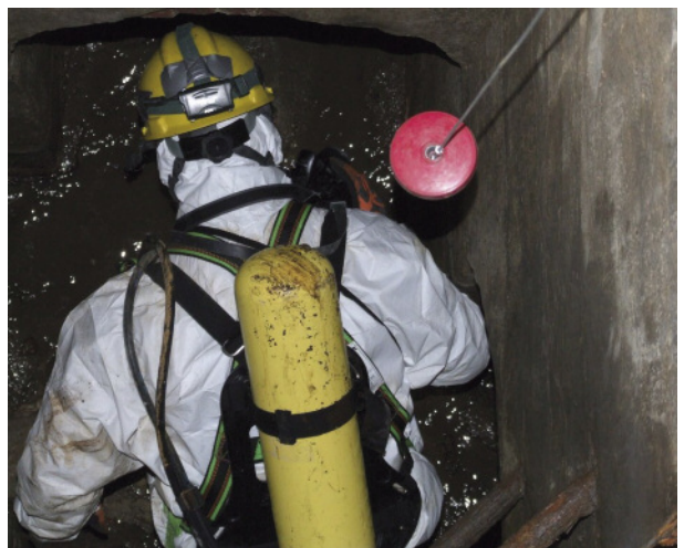
Fig. 2 Uso di un autorespiratore durante un'ispezione nelle rete fognaria.
